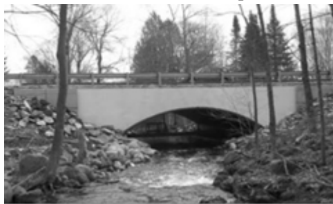
Рис. 2. Вид арочного моста после асфальтирования
