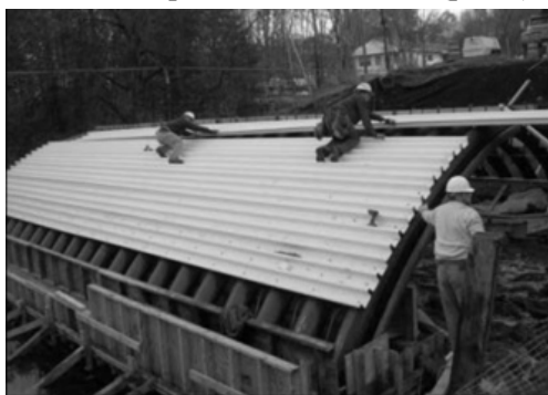
Рис. 1. Монтаж профнастила
