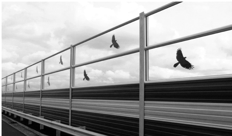
Рис. 1. Пример шумозащитного экрана с нанесением изображения хищных птиц на прозрачные участки панели
