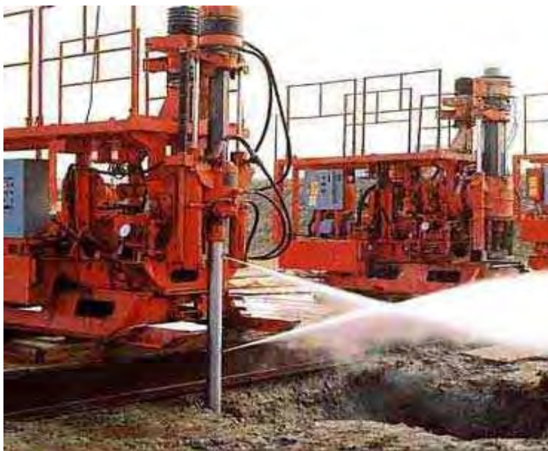
Рис. 4. Расположение нагнетательных насадок
