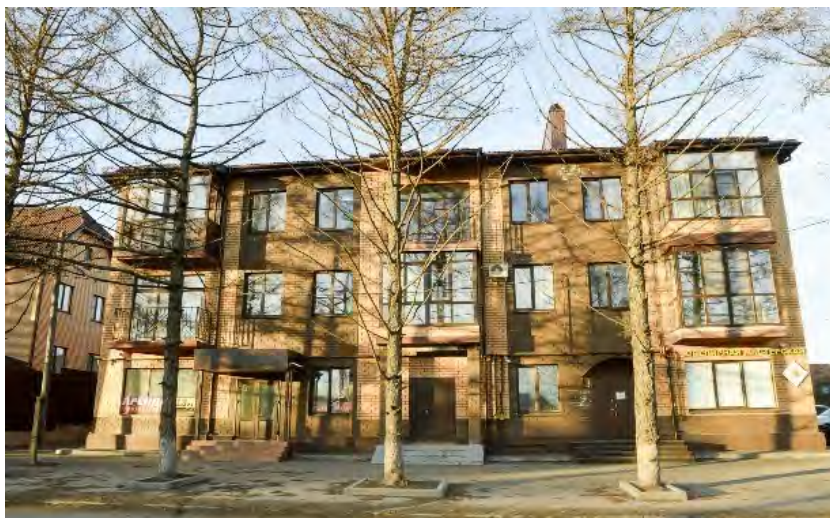
Рис. 3. Дом №43/6 по улице Станиславского/Леваневского
