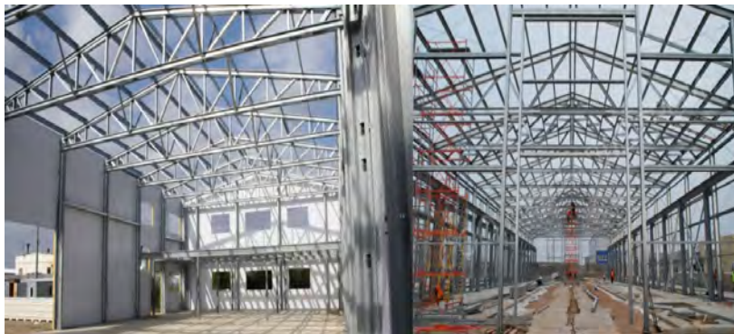
Рис. 2. Большепролетные сооружения промышленного назначения
